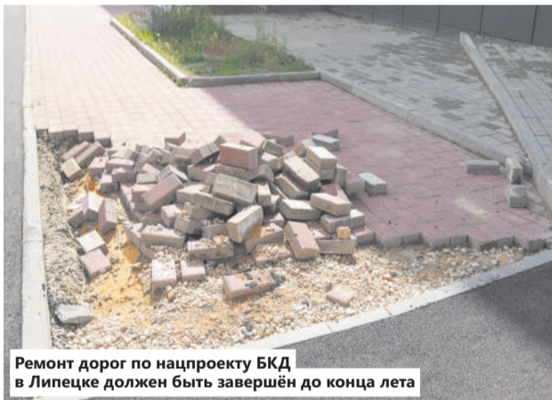
Если по завершении работ будут выявлены недостатки, подрядчик исправит их за свой счёт
